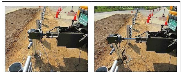
<지주 시험체 설치>
